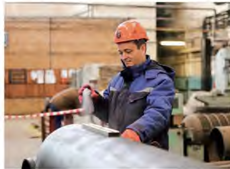
Александр Белов проводит капиллярный контроль металла трубы перед сваркой
