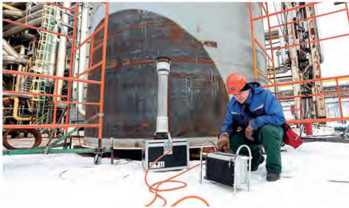
Так устанавливают параметры на аппарате рентгена постоянного действия, чтобы исследовать качество сварных швов
